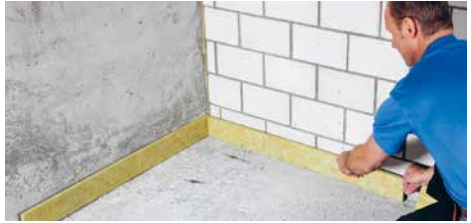
Als Randstreifen von schwimmenden Unterlagsböden.
