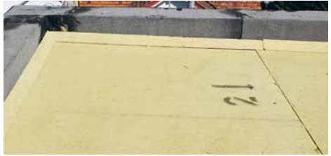
Dachrandkeile bei Aufbordungen im Flachdach.
